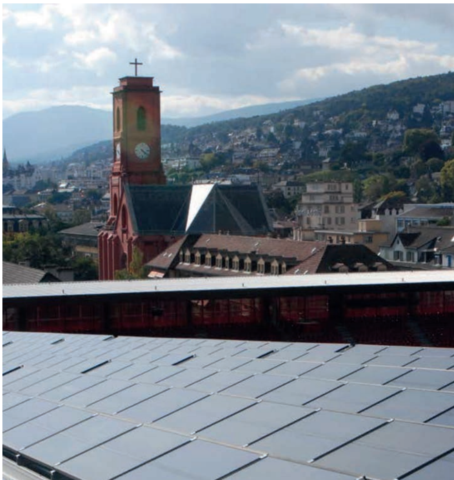
Panneaux solaires sur le stade de la Maladière
