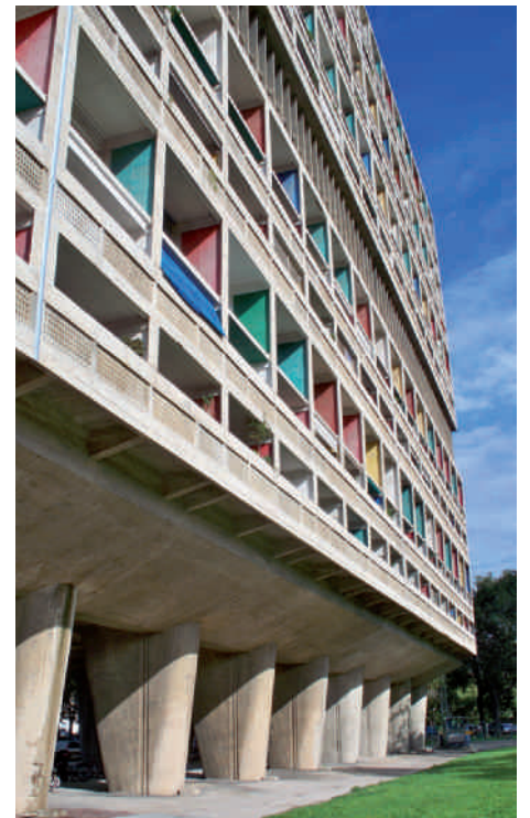
Unité d'habitations à Marseille, Le Corbusier
